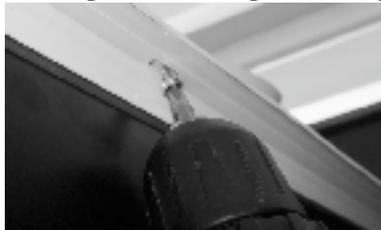
12. Скрепить верх кабины и дугу при помощи уголков - фиксаторов.
