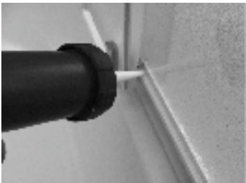
**Перед установкой душевой кабины внизу шторки, рамок со стеклом и функциональной панели на профиль приклейте уплотнитель, прилагаемый в комплекте.**
