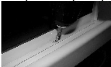
9. Обработать прозрачным герметиком стыки, указанные стрелками
