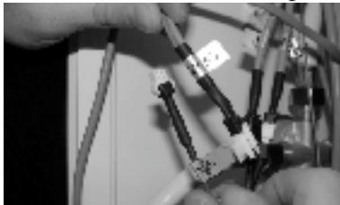
16. Подключить провода от электронного блока к устройству защитного отключения
